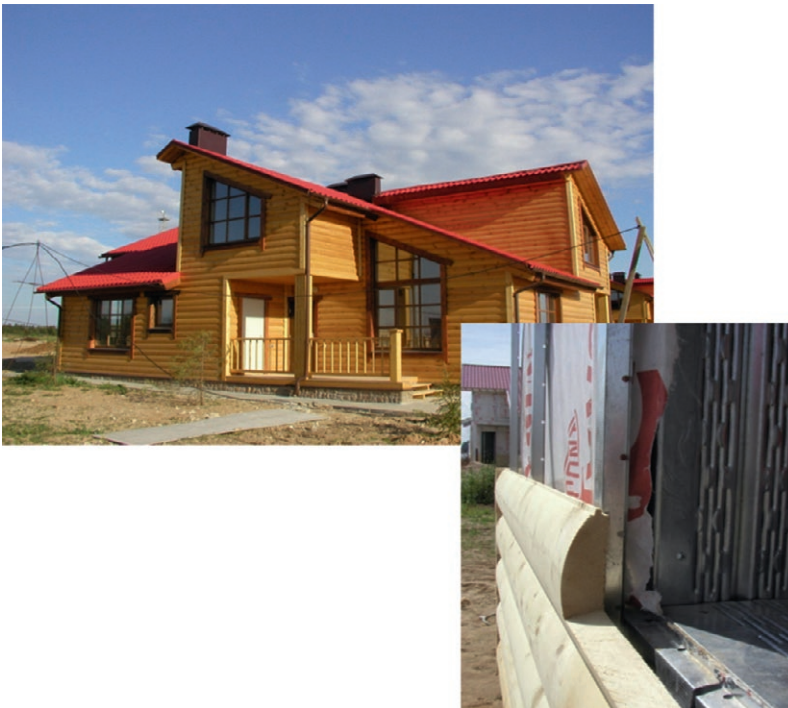
Облицовка деревянными досками типа «блок-хаус» по форме и конфигурации напоминающей деревянный брус
