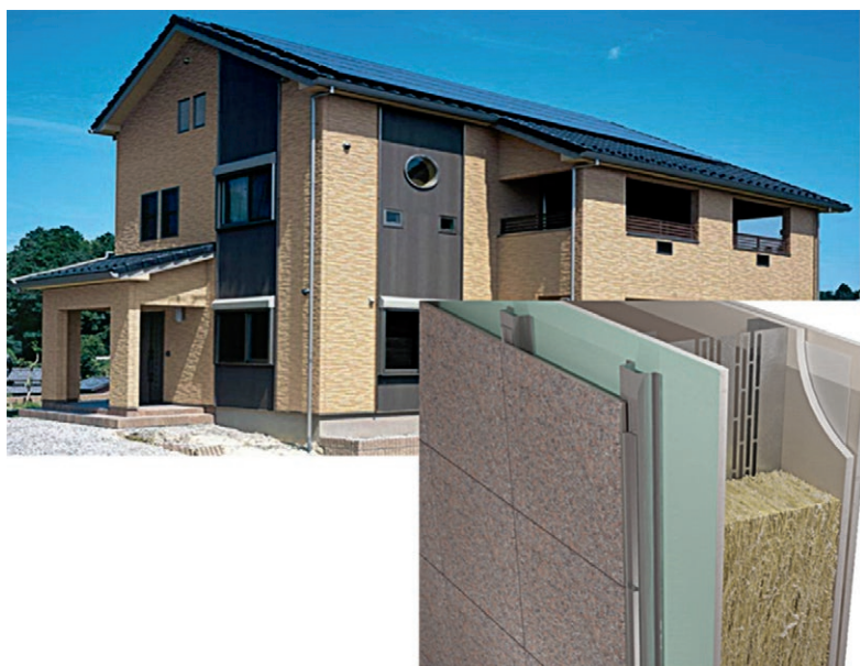
Облицовка из фиброцементных листов разного размера, фактуры и цвета
