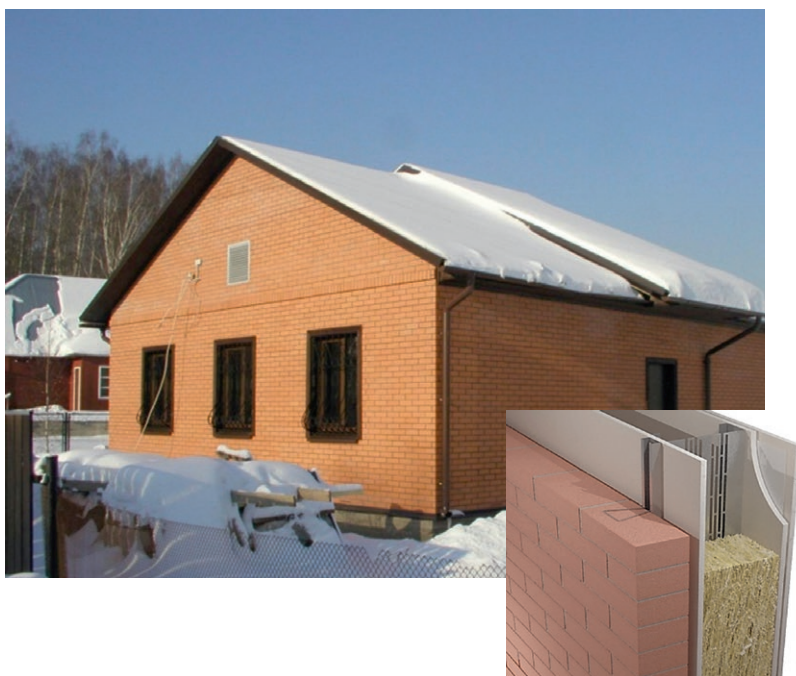
Облицовка фасадным или обычным кирпичом
