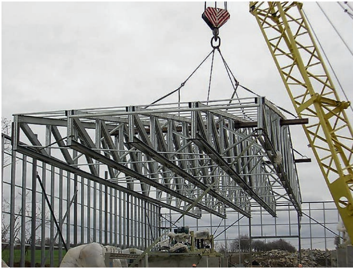
Рис. 11.4. Монтаж стропильных ферм, объединённых в блок (модуль)
