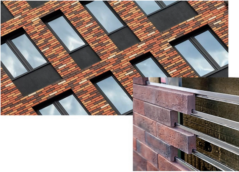
Облицовка клинкерной плиткой, имитирующей натуральные кирпичи разных размеров и цветов
