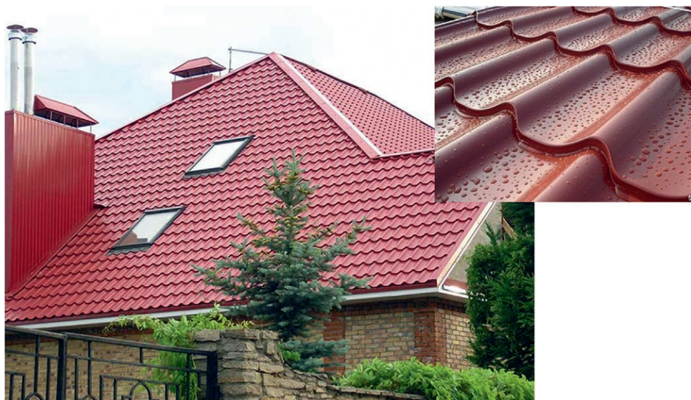
Рис. 13.2. Скатные кровли с применением металлочерепицы
