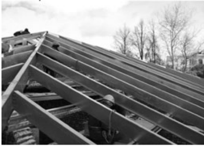
Рис. 11.8. Узел примыкания стропильных балок к главной коньковой балке
