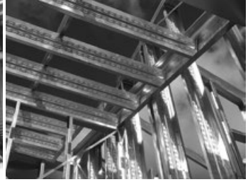
Рис. 9.10. Общий вид чердачного ненесущего перекрытия мансардного этажа фундаменту
